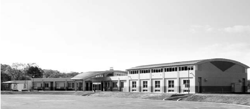
錦城学園改築（指定知的障害者更生施設）
