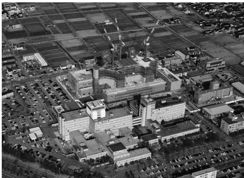
県立中央病院(建設工事)
